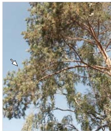
Bogig überhängender, kopflastiger Ast an Nadelbaum (Kiefer)
