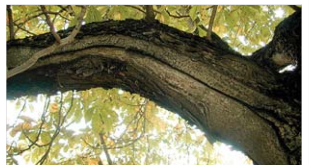
Überwallter Riss eines Unglücksbalkens
