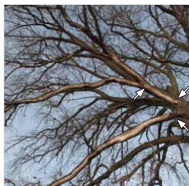
Rindenbeschädigung bis in die Vergabelung von Starkästen und Stämmlingen
