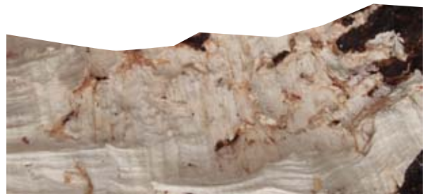
Die Holzstruktur in den gemeinsamen Jahrringen ist dem Kraftfluss angepasst.
