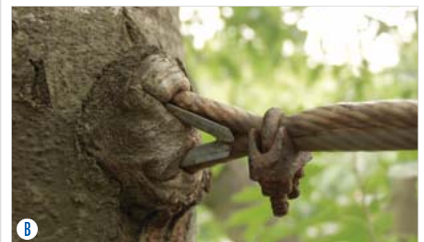
A Feuerverzinkter Stahlseilanker B Stahlseilanker mit plastikummanteltem Stahlseil
