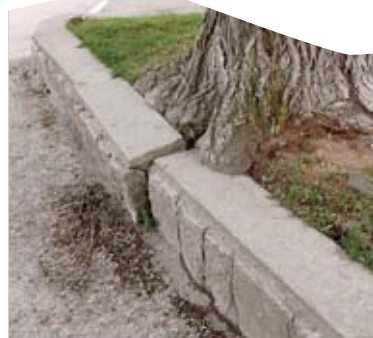
Bordstein als eingewachsene Baumstütze
