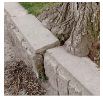
Nachgebender Bordstein: instabile Stütze
