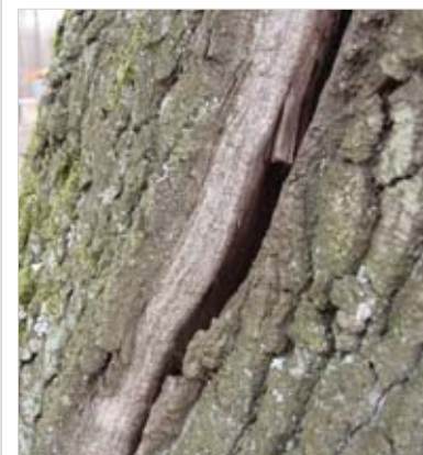
Fäule durch einen Riss in einer Esche
