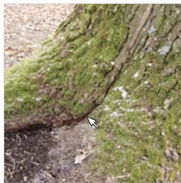
Riss läuft bis in den Boden
